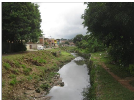
Figura 11. Encontro do córrego do Capão com o córrego Vilarinho, no bairro Lagoinha
