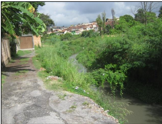
Figura 14. Conjunto habitacional de baixa renda localizado as margens do córrego do Capão, no bairro Lagoa.
