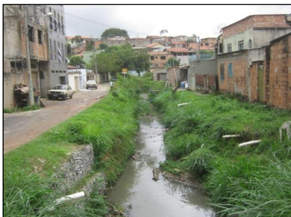
Figura 7. Disposição inadequada de esgoto doméstico no Bairro Piratininga.
